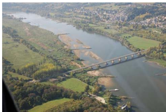
Système d'épis en aval d'Oudon – bancs végétalisés difficilement remobilisables en crue
