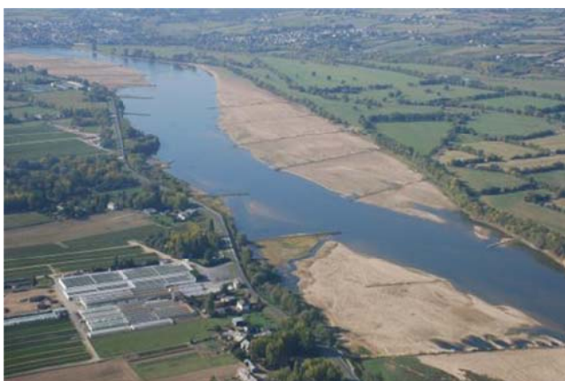
Système d'épis en amont d'Ingrandes – bancs meubles partiellement remobilisables en crue
