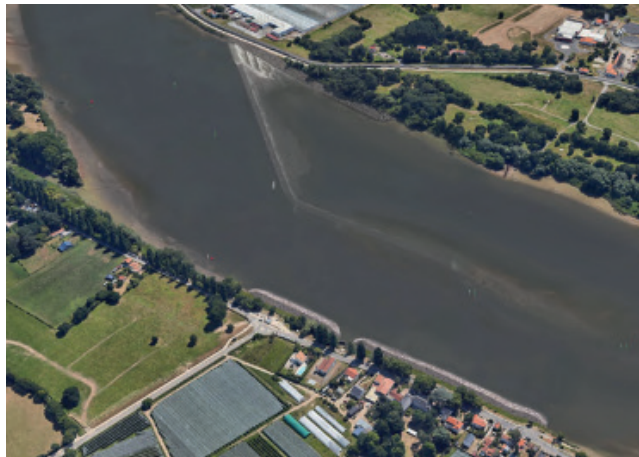
Photomontage présentant l'ouvrage de Bellevue et la zone d'optimisation piscicole à venir, en période d'étiage et à basse mer
